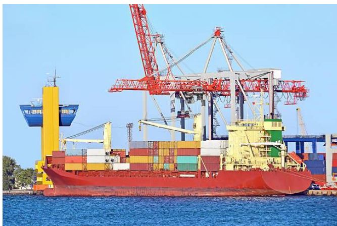
Рис. 3. Причальний контейнерний кран-перевантажувач
