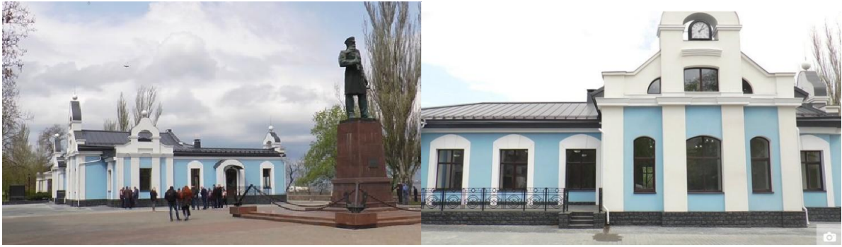
Рис. 3.3. Зовнішній вигляд після оздоблювальних робіт. Світлина автора. 2022 р.
