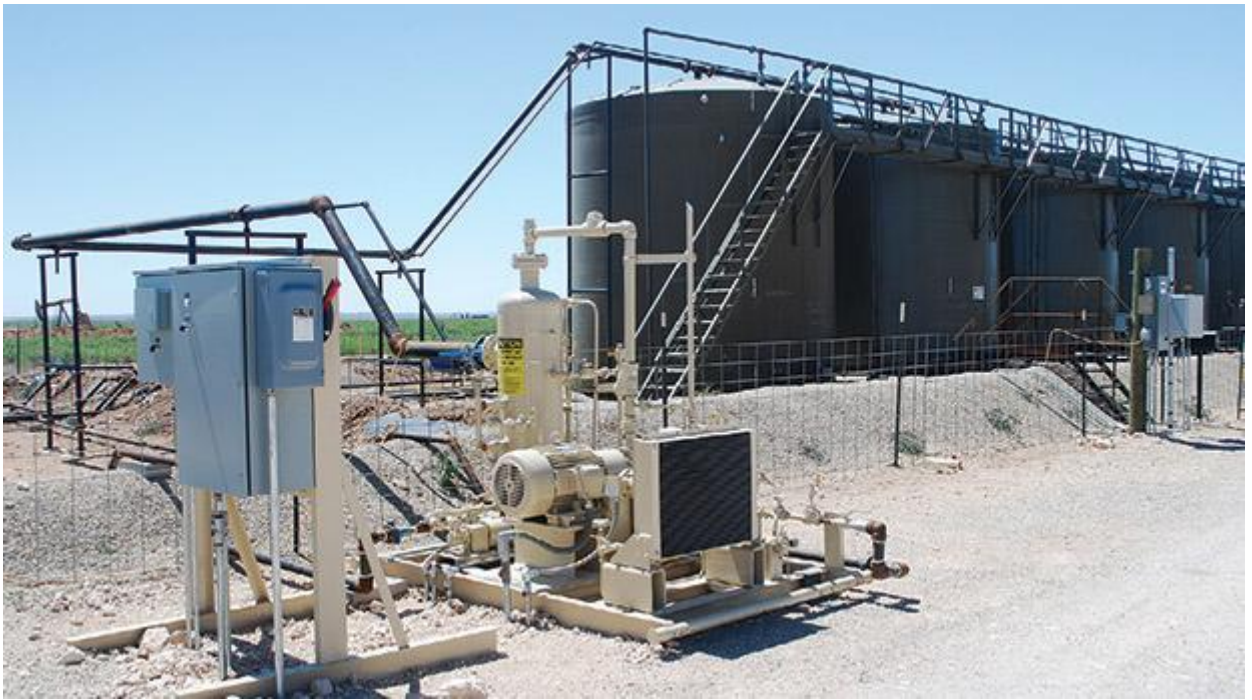
Рисунок 4.1. Установка рекуперации парів нафтопродуктів (VRU) [62]
