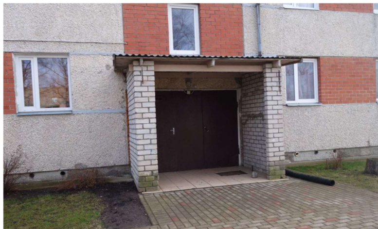
Рисунок 2.3 Загальний вигляд дверей будівлі
