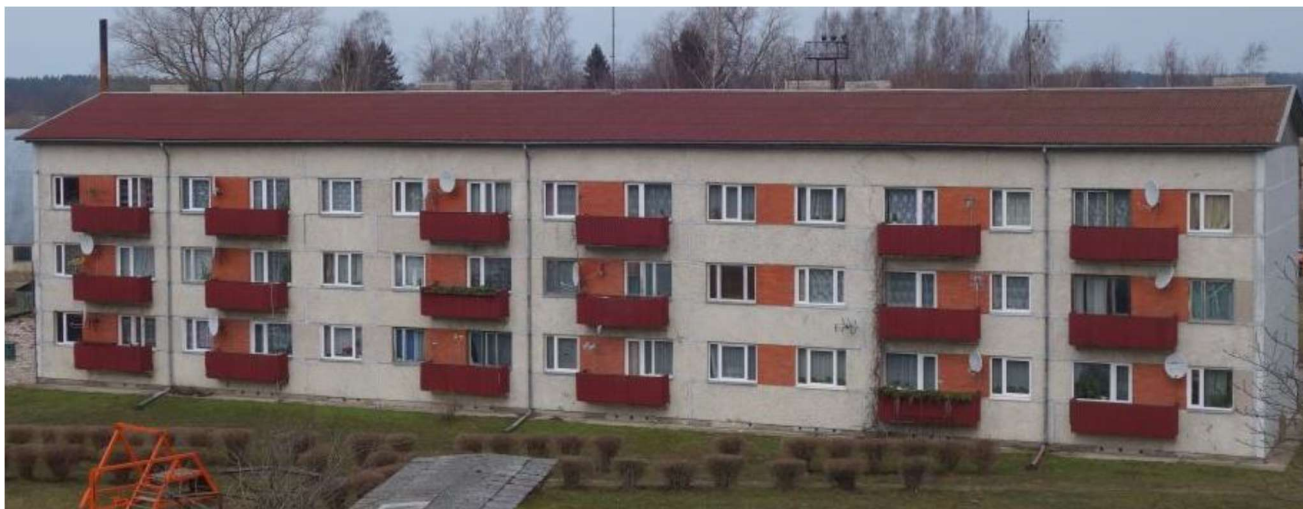
Рисунок 1.1 Загальний вигляд будівлі
