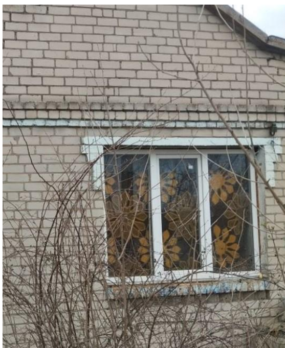
Рисунок 1.1. Зовнішні стіни будівлі з силікатної цегли
