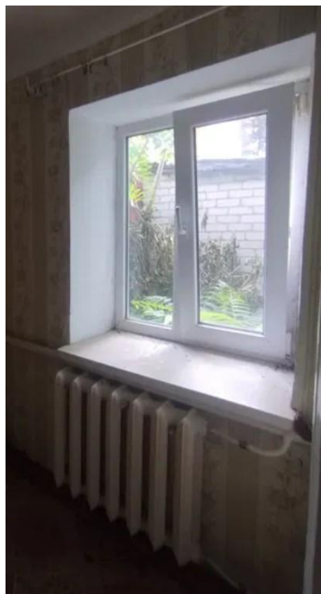
Рисунок 1.2. Світлопрозорі конструкції (вікна)
