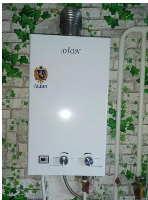
Рисунок 1.6. Індивідуальний проточний газовий водонагрівач
