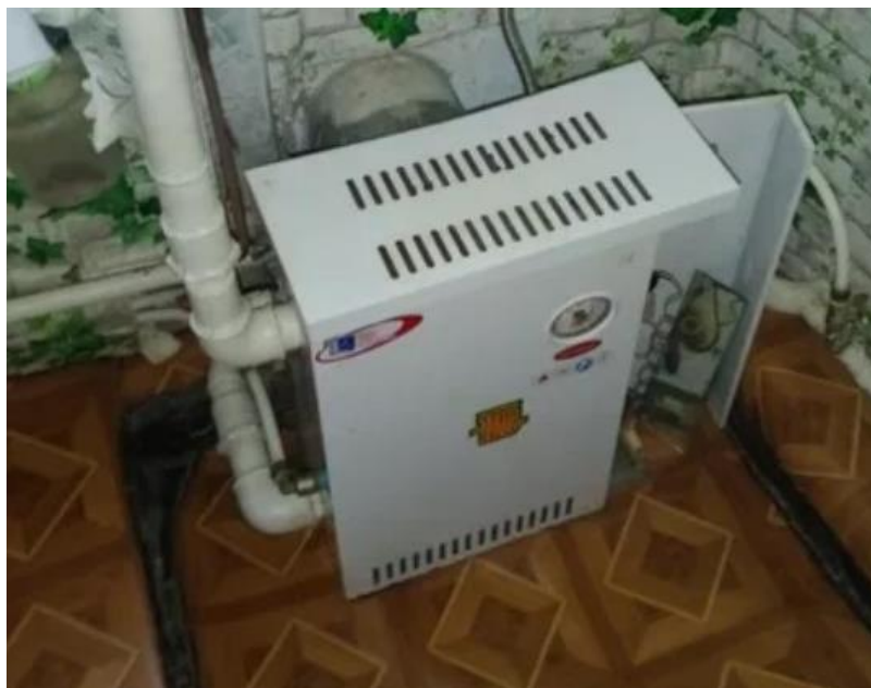
Рисунок 1.4. Одноконтурний газовий котел підлогового типу
