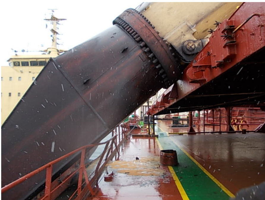
Рис. 2. Пошкодження поворотного вузла та основи стріли
