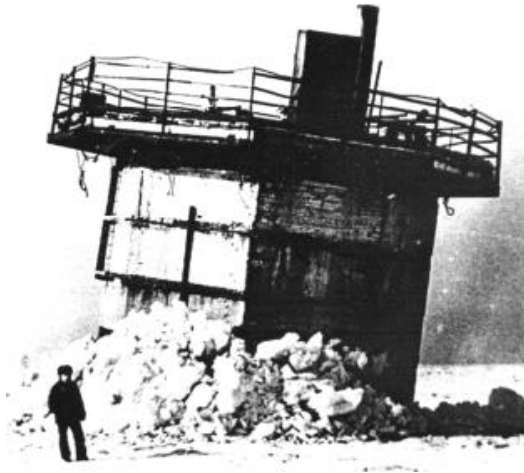
Рисунок 1.2 — Опорна конструкція платформи
