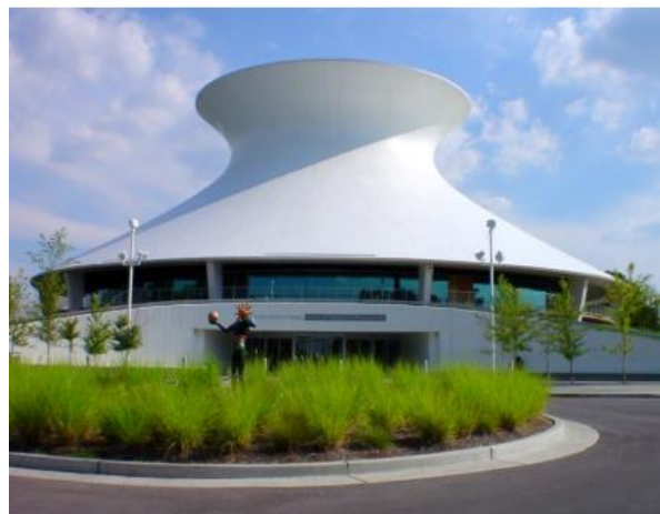
Рис. 13. Форма поверхонь однопорожнинного гіперболоїда: а – градирні (фото автора); б – будівля планетарію
