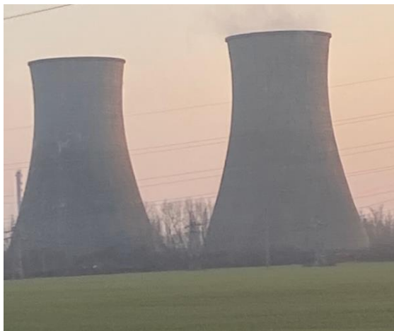
Рис. 13. Форма поверхонь однопорожнинного гіперболоїда: а – градирні (фото автора); б – будівля планетарію
