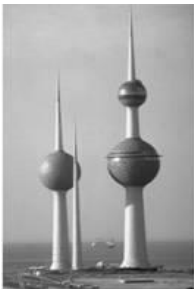
Рис.6. Водонапірна вежа, Кувейт, 1979р.
