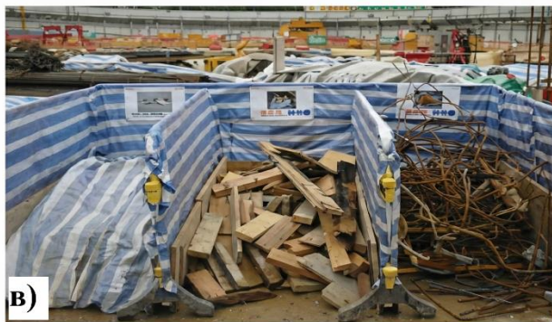
Рис. 4.9 – Порівняльна характеристика способів організації зберігання відходів руйнувань: а) хаотичне накопичення змішаних відходів; б) стаціонарні бетонні відсіки для роздільного зберігання фракцій; в) організація тимчасових постів сортування; г) контейнерна система збору для запобігання змішуванню.
