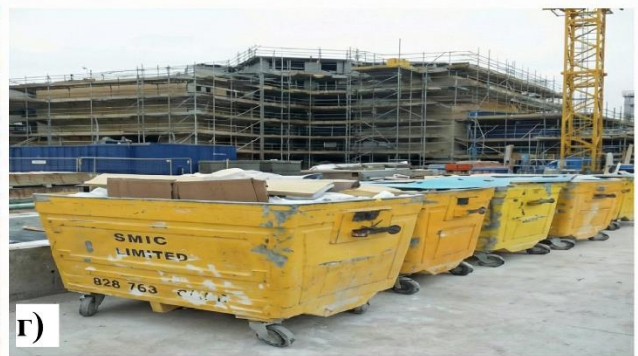
Рис. 4.9 – Порівняльна характеристика способів організації зберігання відходів руйнувань: а) хаотичне накопичення змішаних відходів; б) стаціонарні бетонні відсіки для роздільного зберігання фракцій; в) організація тимчасових постів сортування; г) контейнерна система збору для запобігання змішуванню.
