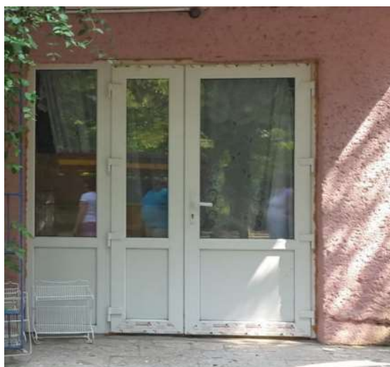
Рис. 3.5. Загальний вигляд дверей
