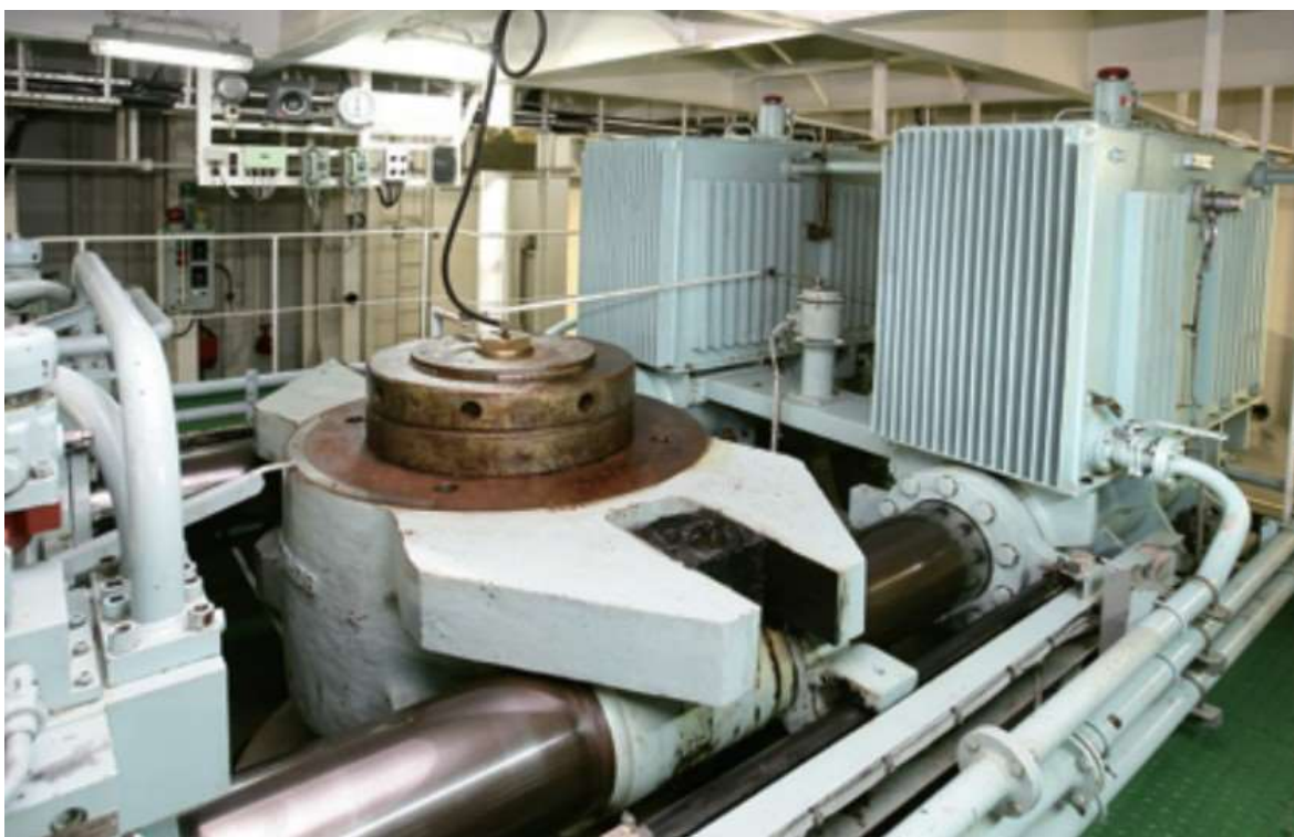
Рисунок 5 – Загальний вид механізму рульової машини YOOWON-MITSUBISHI YDFT-335-2
