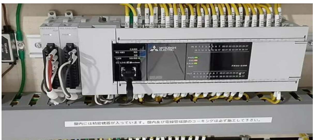
Рис. 3.2. – Типовий процесорний модуль ПЛК
