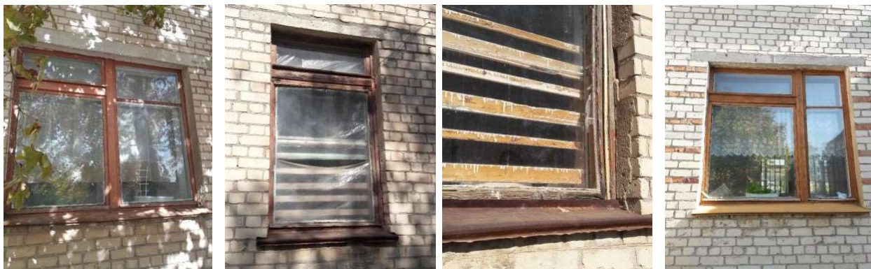
Рисунок 2.2 Загальний вигляд вікон будівлі
