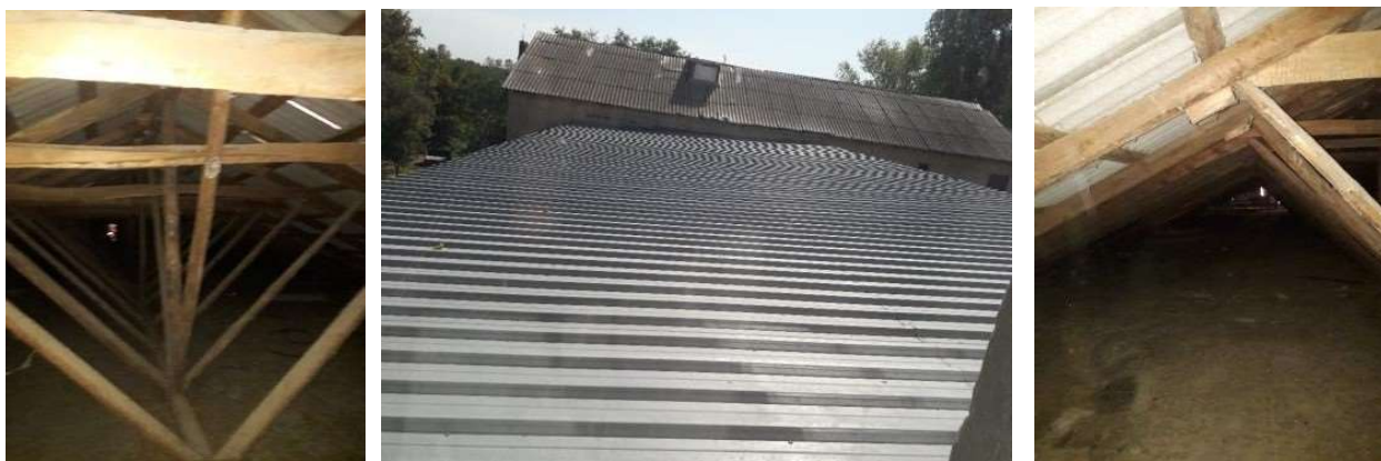
Рисунок 2.4 Зовнішній вигляд горища будівлі
