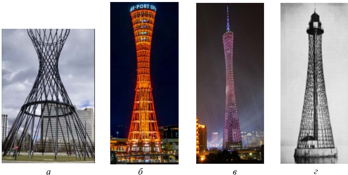
Рис.18. Сітковий каркас поверхні одно порожнинного гіперболоїда: а - архітектурна конструкція; б – вежа порту Кобе; в – телевежа Ганьчжоу; г – Аджигольський маяк
