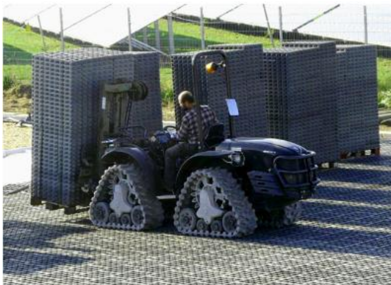
Рис. В.1. Укладання палетів з газонними решітками ТТЕ
