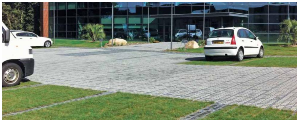
Рис. А.1. Парковка, Інститут будівництва (Франція)
