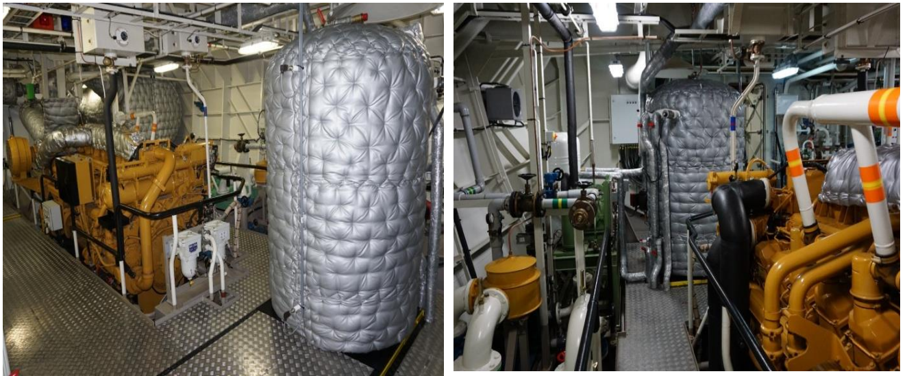
Рисунок 1.8 – Розміщення елементів теплоакumuлюючої системи на буксирі ZP Bison [36]
