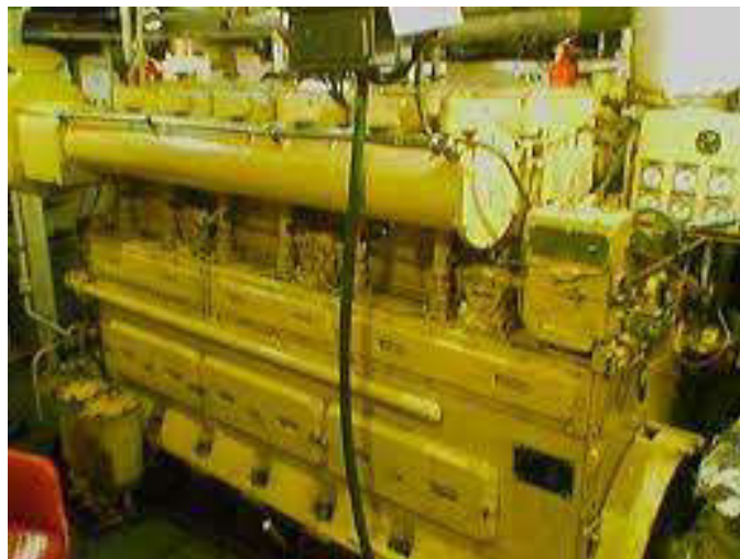
Рис. 1.1 – Двигун 6Ч 23/30 в якості силового агрегату для генератору ДГР2А
