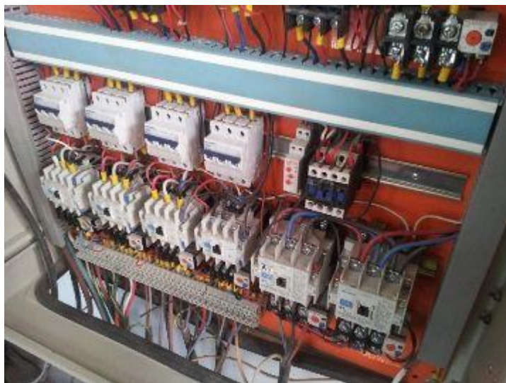
Рисунок 2.1 – Станція керування ліфтом "ARL300/ВМП 2"
