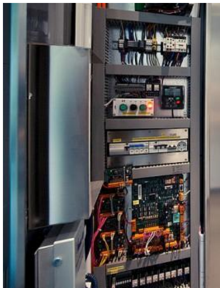
Рисунок 2.6 – Автоматика ліфту
