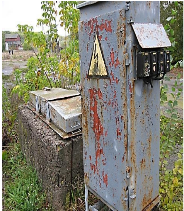
Рисунок 2 – Сучасний стан причальних пристроїв електричного живлення
