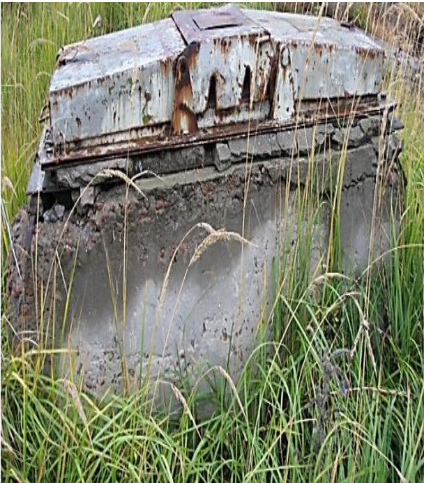
Рисунок 2 – Сучасний стан причальних пристроїв електричного живлення
