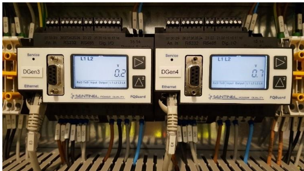
Рисунок 3.1 – Аналізатори гармонік PQGuard 605 для монтажу на панель/розподільний щит
