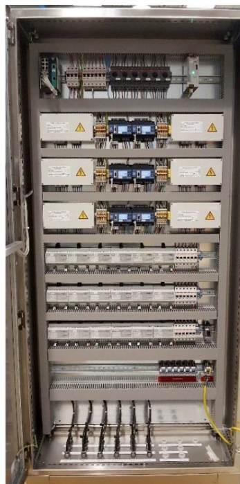
Рисунок 3.2 – Система моніторингу якості електроенергії (PQ) з PQGuard 605, встановленими по одному на кожен генератор
