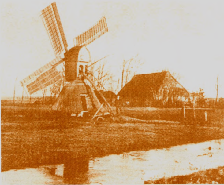
Мал. 4.19. Німецький вітронасосний млин для зрошування земельних ділянок
