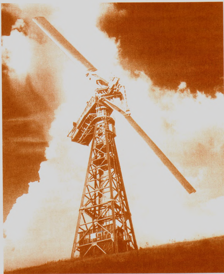
Мал. 4.29. Загальний вигляд ВЕС «Сміт–Путнем» потужністю 1250 кВт
