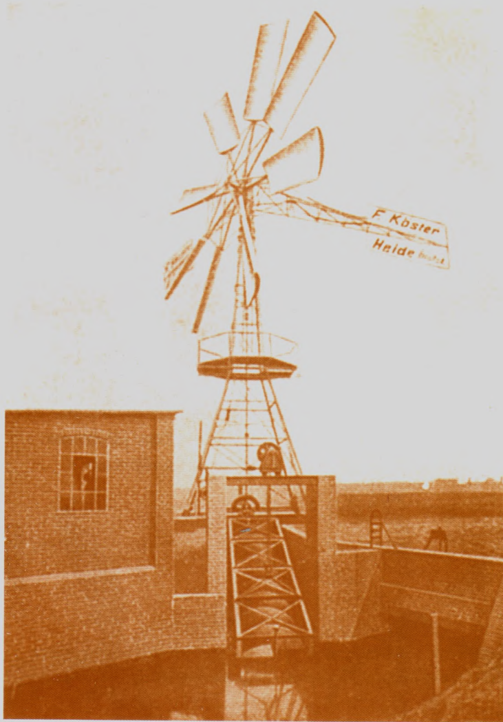
Мал. 4.22. Вітроустановка для накачування води за допомогою підйомного гвинта
