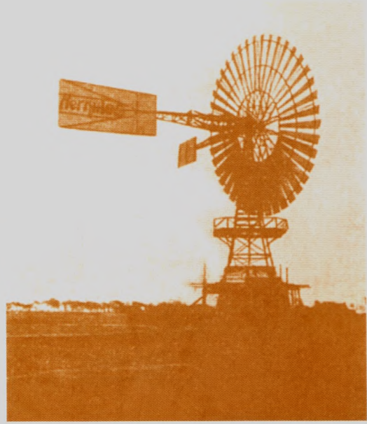
Мал. 4.20. Вітронасосна установка з вітроколесом «Геркулес»
