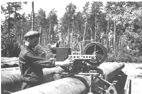
Рис.6. Зварювальний трактор на трасі газопроводу Дашава - Київ - Москва
