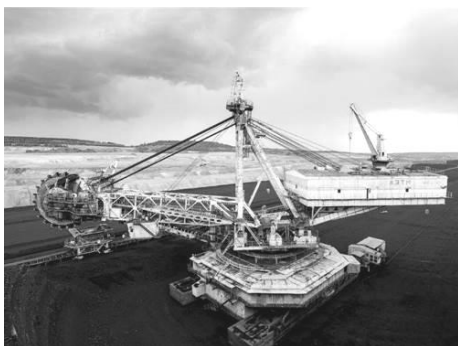
Рис. 9. Роторний екскаватор на крокуючо-рейковому ході ЕРКРД-5250
