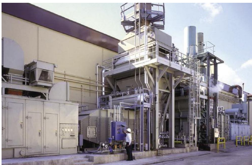
Рис. 3.5. Когенераційна установка з двигуном "Centaur 40" потужністю 3,5 МВт компанії "Solar Turbines Inc." на території фармацевтичного заводу в м. Ірвін (Каліфорнія, США)
