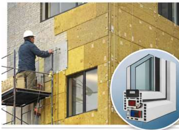
Рис. 5.1. Утеплення фасаду та заміна вікон як приклад робіт з підвищеними вимогами безпеки [17]
