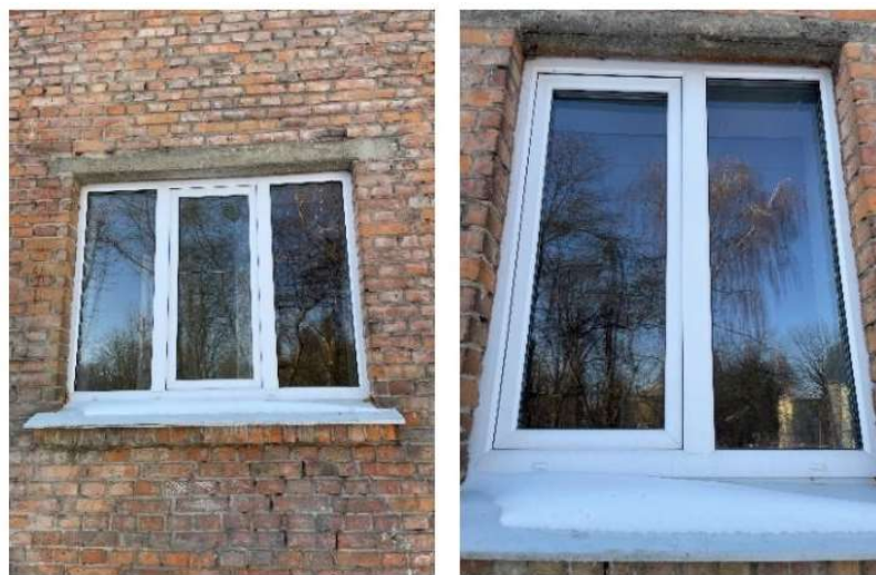
Рис. 2.2. Стан віконних блоків і вузлів примикання [17]
