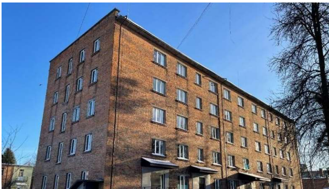
Рис. 1.1. Загальний вигляд будівлі гуртожитку [17]
