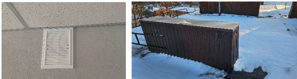
Рис. 2.7. Вентиляційна решітка в приміщенні та стан вентиляційних виводів на покрівлі [17]
