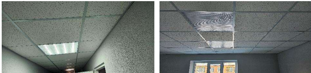
Рис. 2.10. Світлодіодне освітлення в коридорах та приміщеннях загального користування [17]
