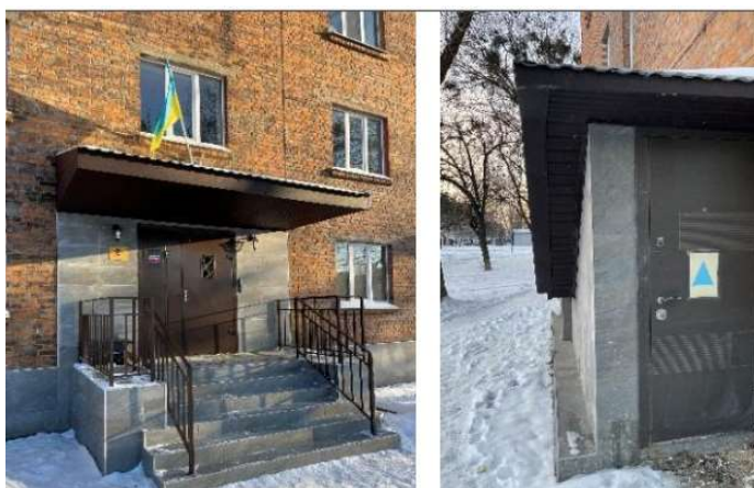
Рис. 2.3. Віконні та дверні конструкції будівлі [17]
