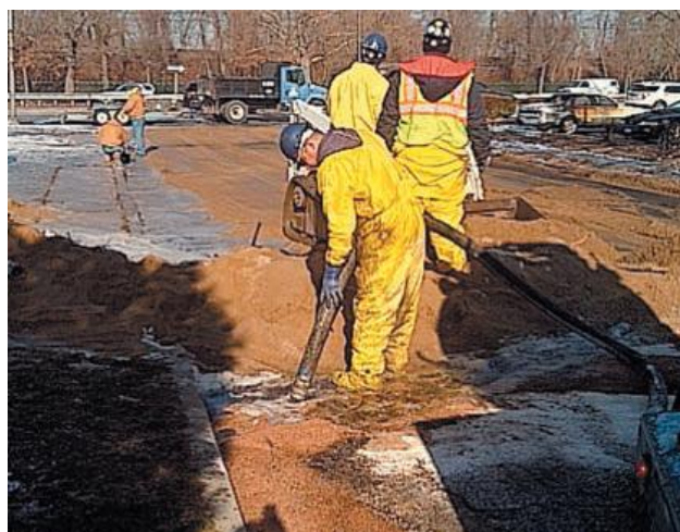
Рис. 3.2 – Збір сорбуючого матеріалу на забрудненій нафтопродуктима ділянці біля залізничного полотна
