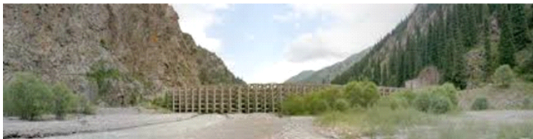
Рис. 7.8. Наскрізна селезатримуюча гребля із залізобетонних елементів
