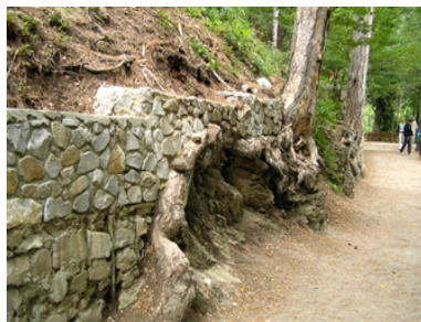
Рис. 7.7. Утримуюча споруда та підпірна стінка для захисту від зсуву
