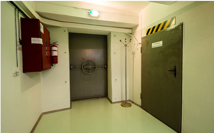
Рис. 6.5. Герметичні двері захисної споруди
