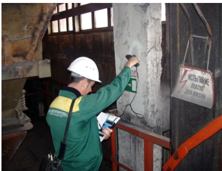
Рис. 11.5. Візуальні обстеження конструкцій
