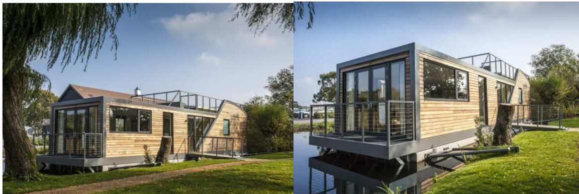
Рисунок 9 - Будинок на воді Bluefield R750
