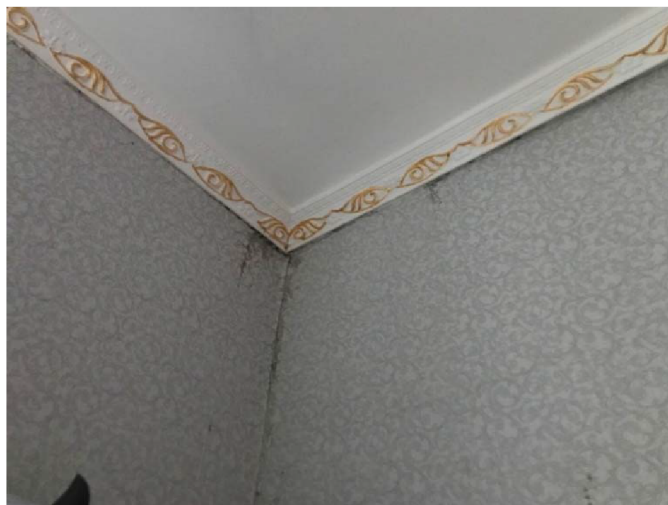
Рис. 3.8. Стан внутрішніх стін будівель.
