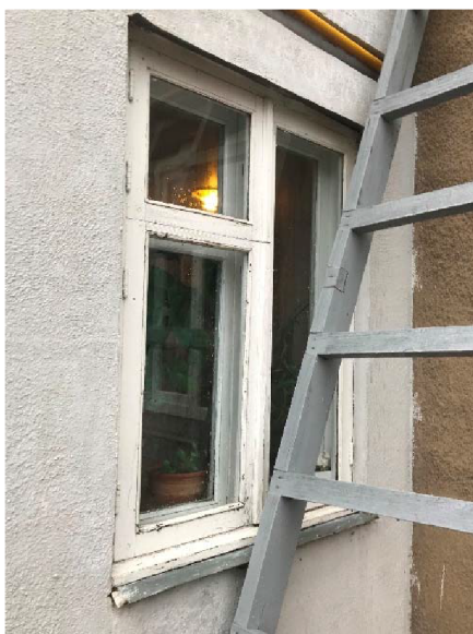
Рис. 3.7. Стан вікон в будівлі
