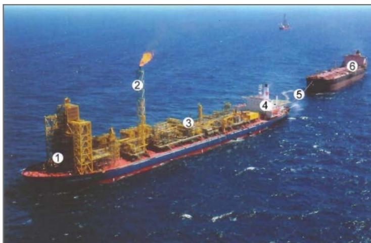
Рис. 3.39. Плавучая эксплуатационная система FPSO:
