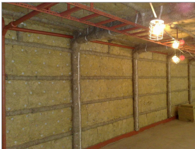
Рис. 4.17. Палуба и переборки, изолированная стекловатой
