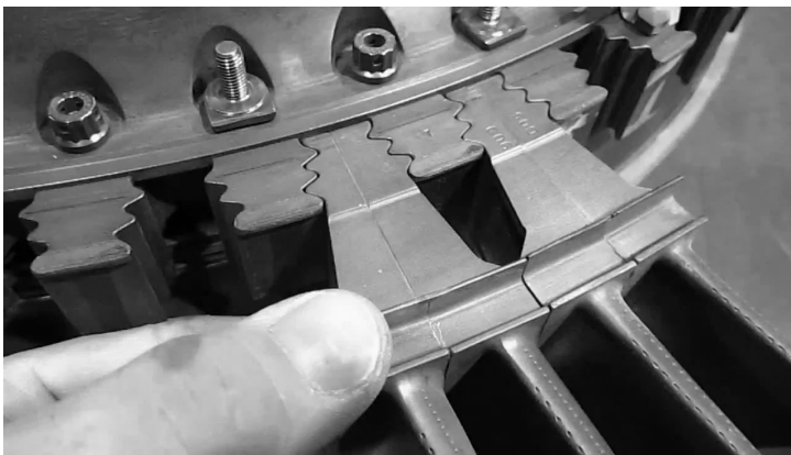
Рис. 1.50. Установлення робочих лопаток по дві в одному пазу
