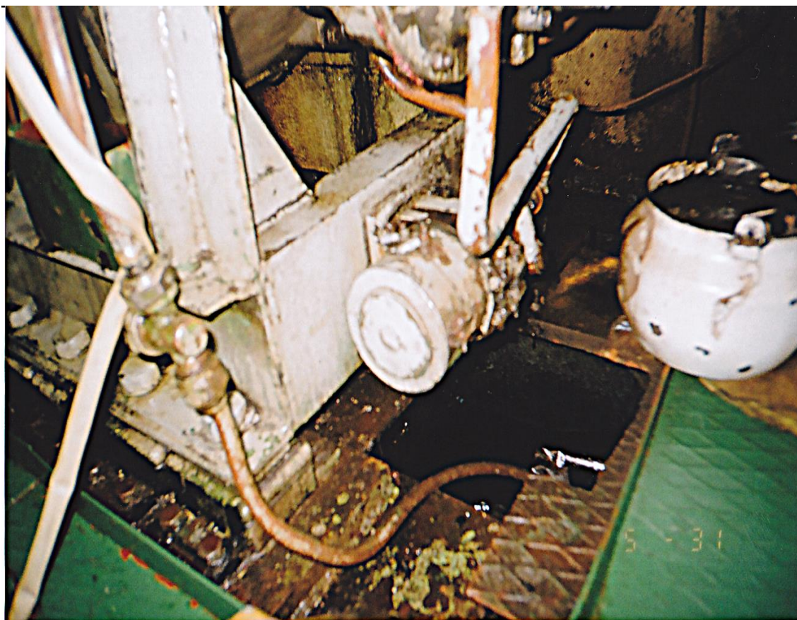
Рисунок 2.13 - Зображення маслозакачувального насосу МЗН-2
