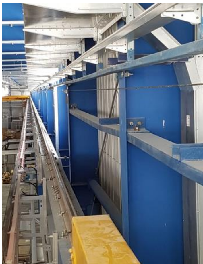
Рисунок 1.3 – Підкрановий шлях
