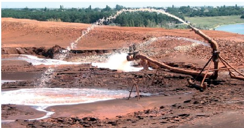
Рис. 4.15. Ємність для складування червоного шламу (Миколаївська область)
