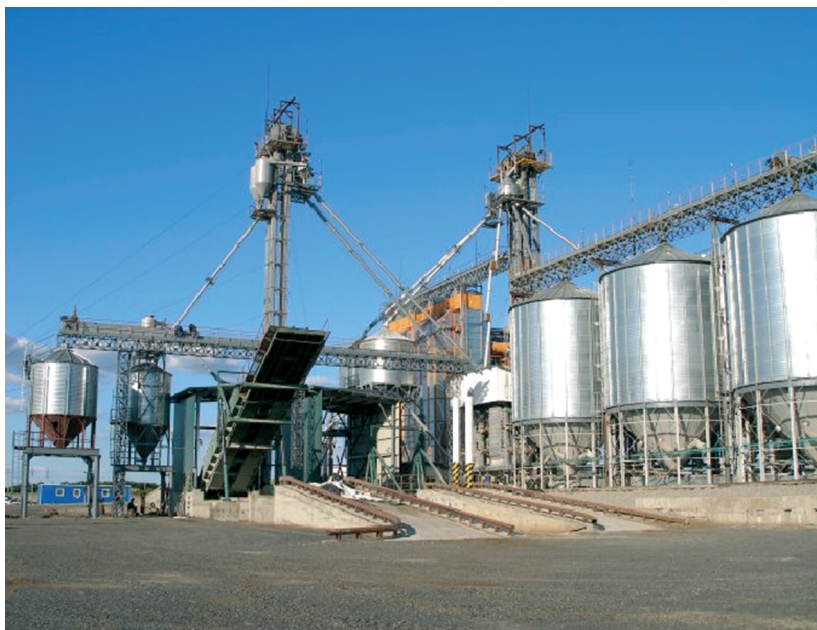
Рис. 4.6. Елеваторний комплекс «Нібулону»
