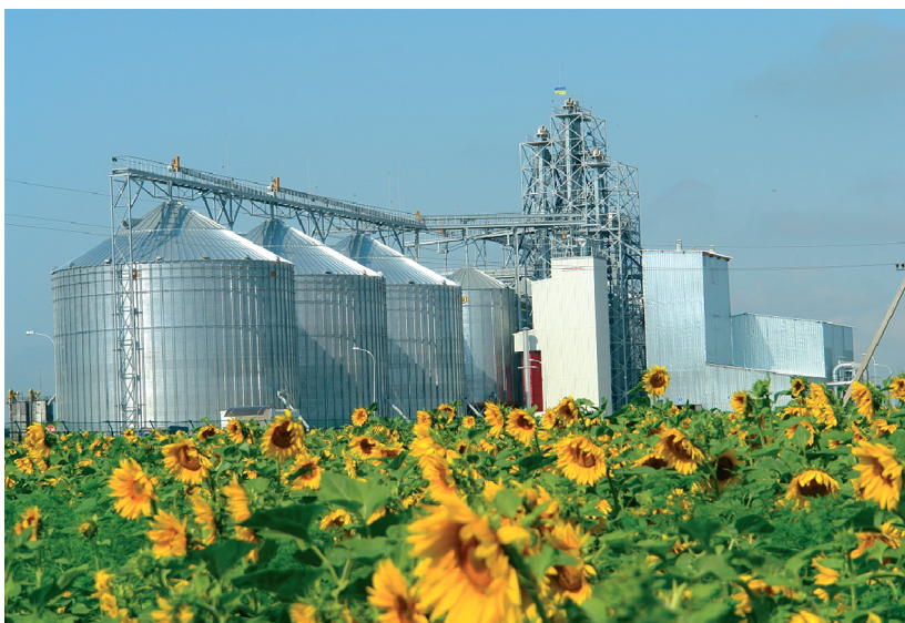
Рис. 4.7. Елеваторний комплекс «Нібулону»
