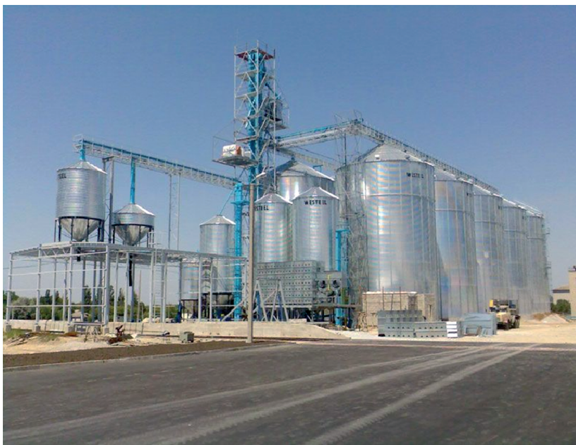
Рис. 4.8. Елеваторний комплекс «Нібулону»
