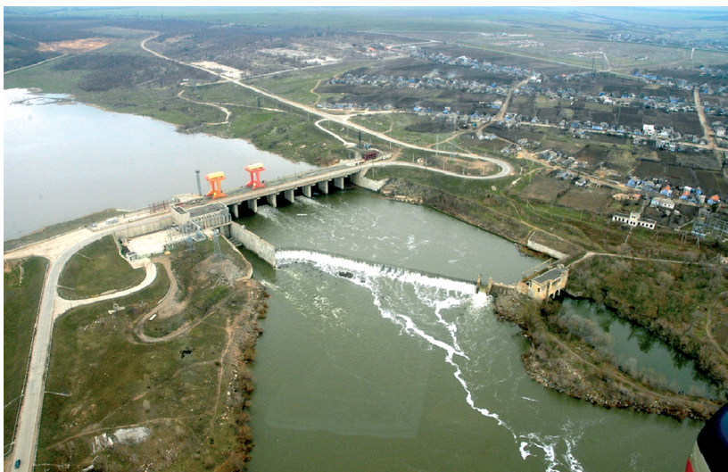
Рис. 4.2. Олександрівське водосховище гідроакумлюючої електростанції (ТГАЕС) у м. Южноукраїнську (Миколаївська область)
