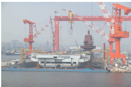
Рис. 5.6. Строительство авианосца в сухом строительном доке с батопортом на верфи в городе Dalian (Китай)
