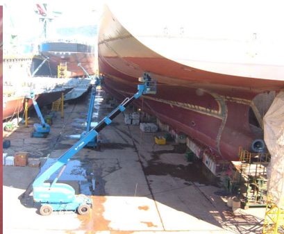
Рис. 5.30. Площадки на колесном ходу при строительстве судов в сухом доке
