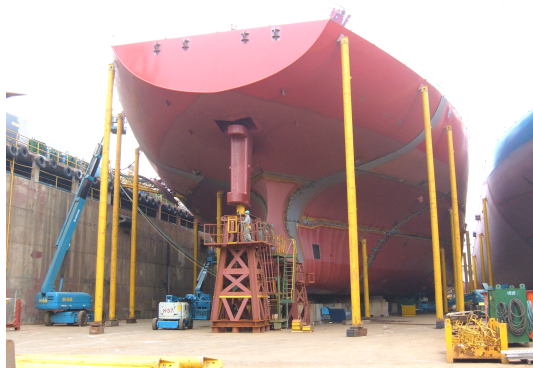
Рис. 5.17. Установка упоров при строительстве корпуса судна
