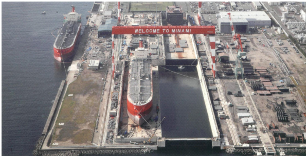
Рис.6.7. Наливная продольная док-камера на верфи Minaminippon Shipbuilding Co. Ltd. (Сингапур)
