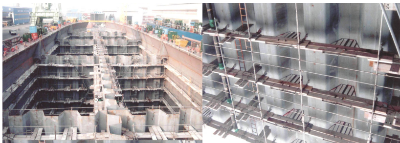
Рис. 5.28. Внутренние строительные леса в трюме строящегося судна
