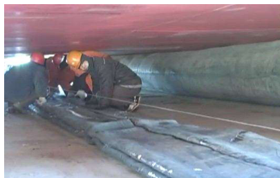
Рис. 6.32. Установка баллонов под судном
