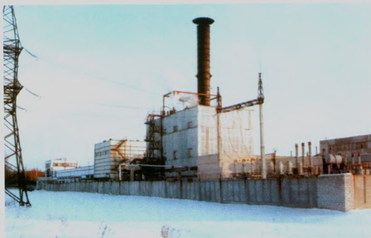
Когенераційна електростанція з 2 двигунами UGT 16000 С у Мозирі (Білорусь)
