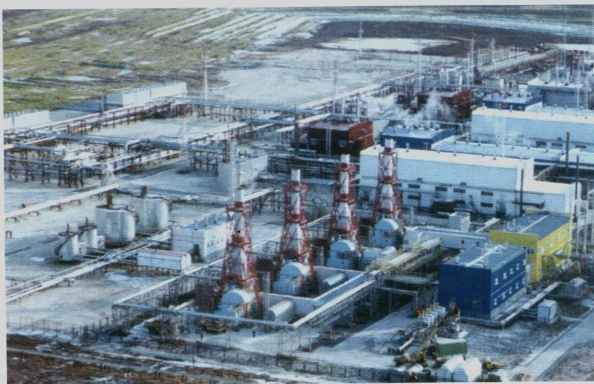
Когенераційна електростанція в Заполяр'ї з 4 двигунами UGT 6000
