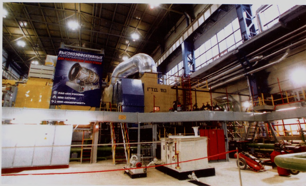
Мал. 3.18. Енергоблок UGT 110000 на Іванівській ДРЕС у Камсомольську, Іванівська обл. (Росія)
