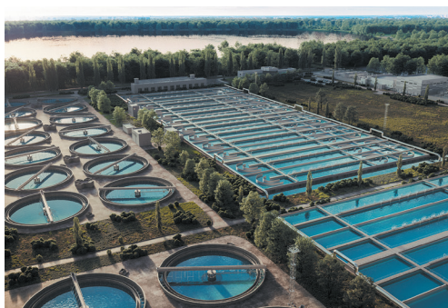
Станція для очищення стічних вод
