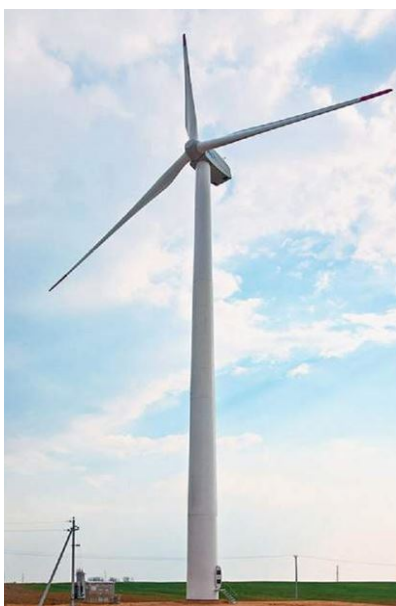
Рисунок 1 – Загальний вигляд вітрогенератора
