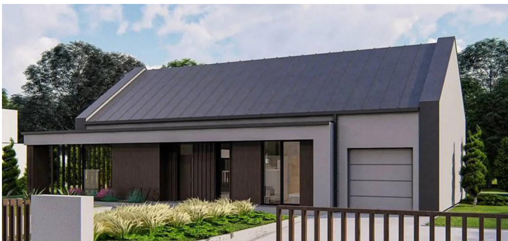
Рисунок 1.1. Зовнішній вид фасаду будівлі 130 м 2
