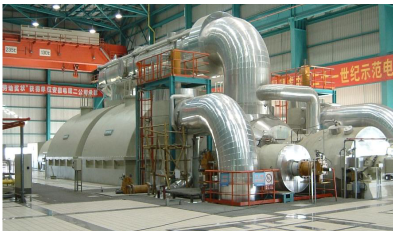
Рис. 8. Приклади енергоблоків з турбіною SST-6000
