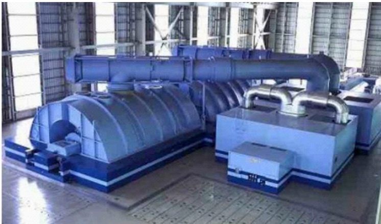
Рис. 11. Двовальна чотирициліндрова турбіна потужністю 1000 МВт компанії "Mitsubishi Hitachi Power Systems, Ltd."
