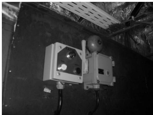
Рисунок 1.2 – Блок керування системи сигналізації контролю дієздатності машинного персоналу
