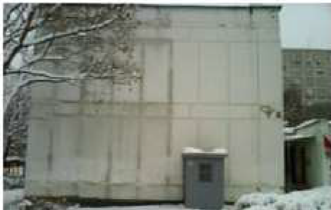
Рис. 3.2. Загальний вигляд стін
