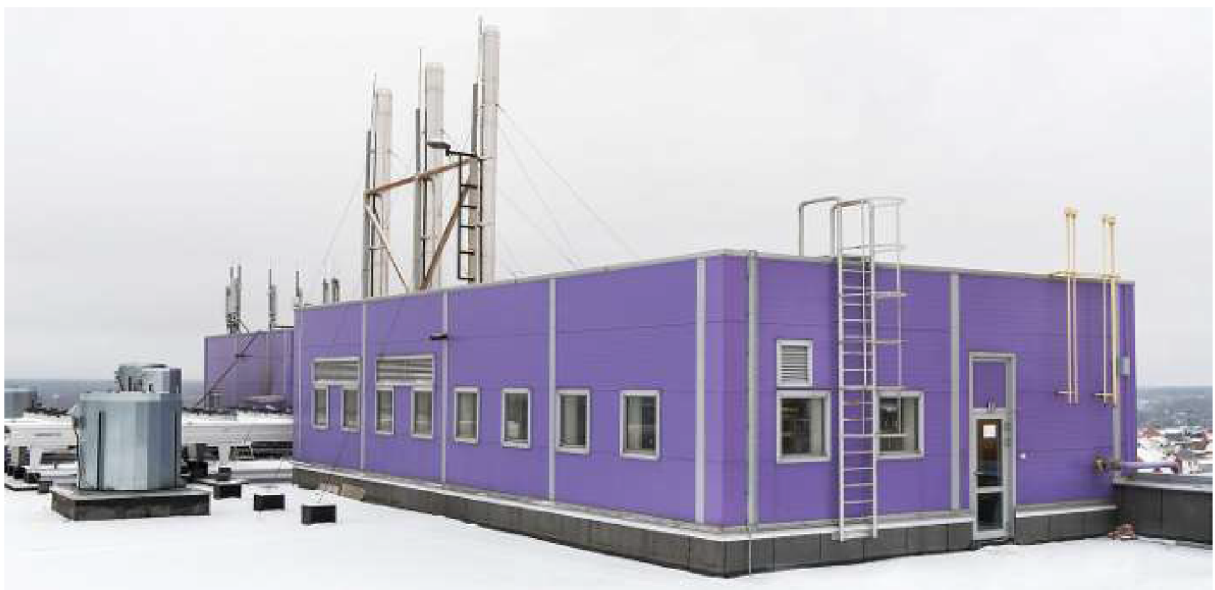
Рис. 1.5 Енергетичне обстеження котельні
