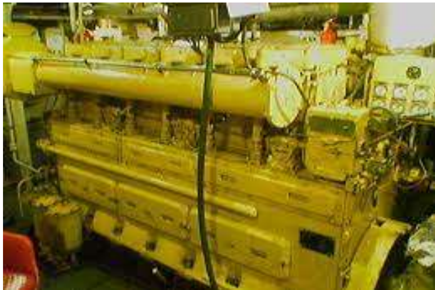
Рис. 1.1 - Двигун-генератор ДГР2А
