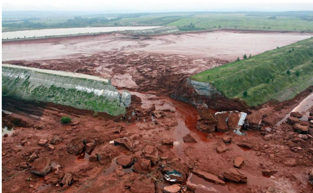
Рис. А.16 – Руйнування греблі хламосховища
