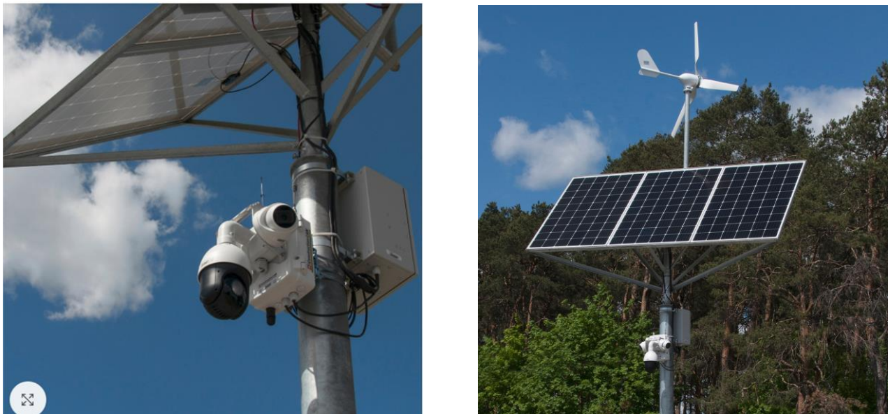
Рисунок 2.3 – Система електроживлення від альтернативних джерел для камер відеоспостереження [30]
