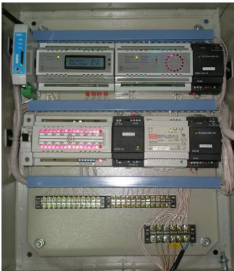
Рис. 4.15. Модель СЕУ: а – щит управління ГА; б – склад моделі СЕУ
