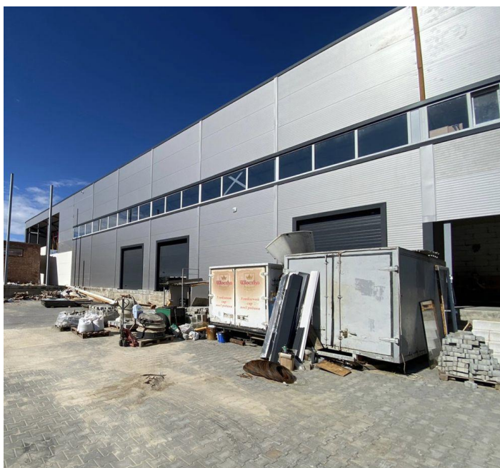
Рис.2.3. Складські приміщення ТОВ «СВАНТОВІТ»
