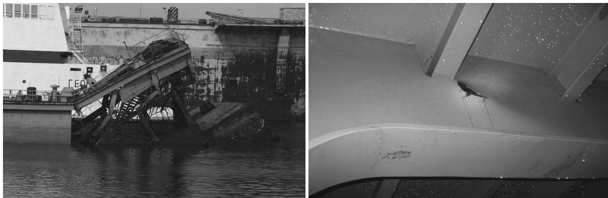
Рис. 1.4. Диформації корпусу плавучого доку: а) значний вигин вежі і понтону; б) деформація металу під стапель-палубою
