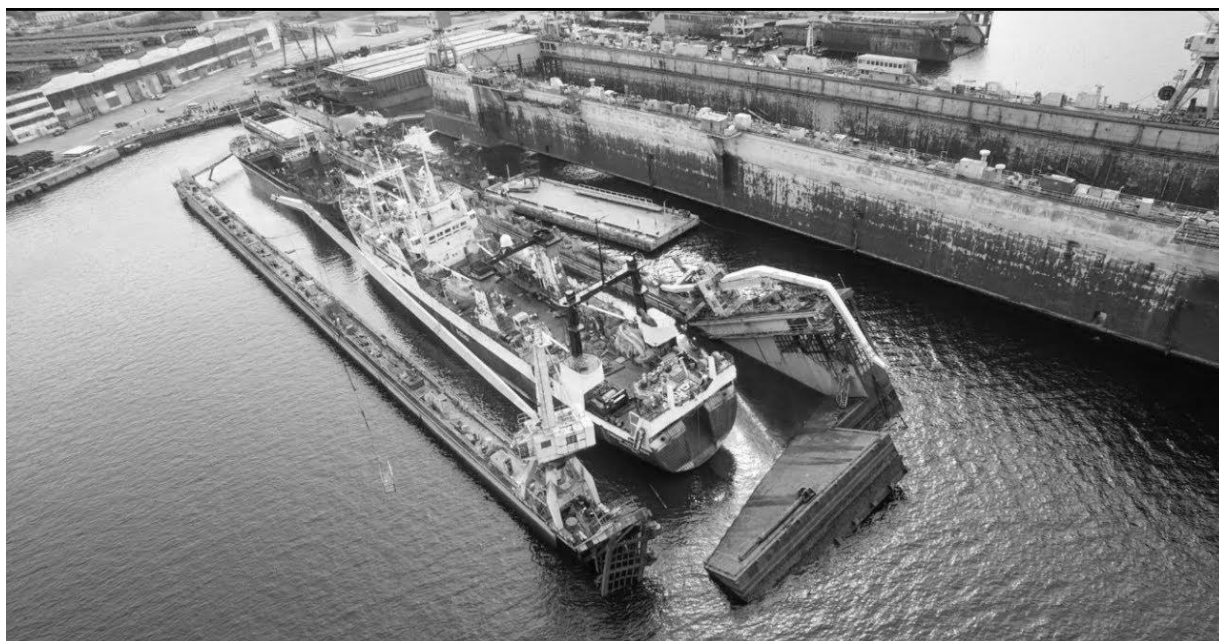
Рис. 1.5. Загальний вигляд переломленого плавучого доку з судном
