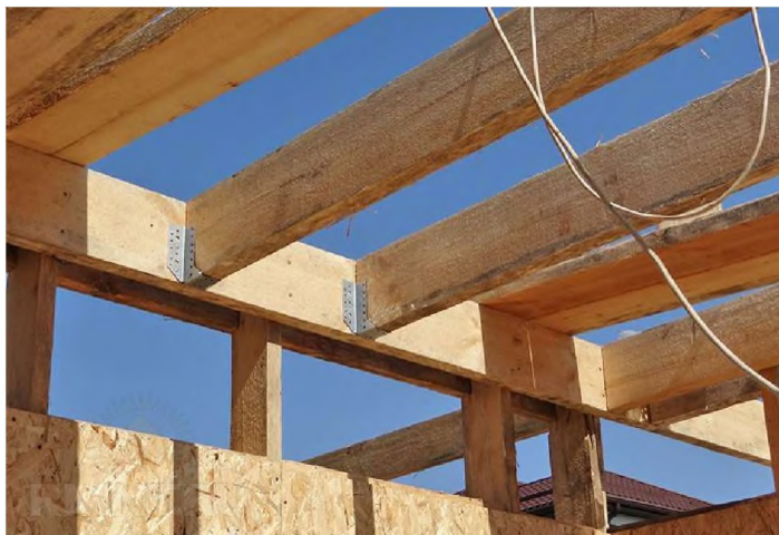
Рисунок 1.2. Дерев'яна балка перекриття.
