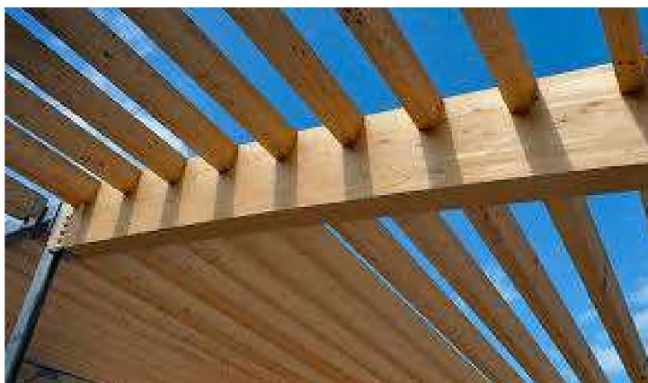
Рисунок 1.1. Міжповерхове балкове перекриття
