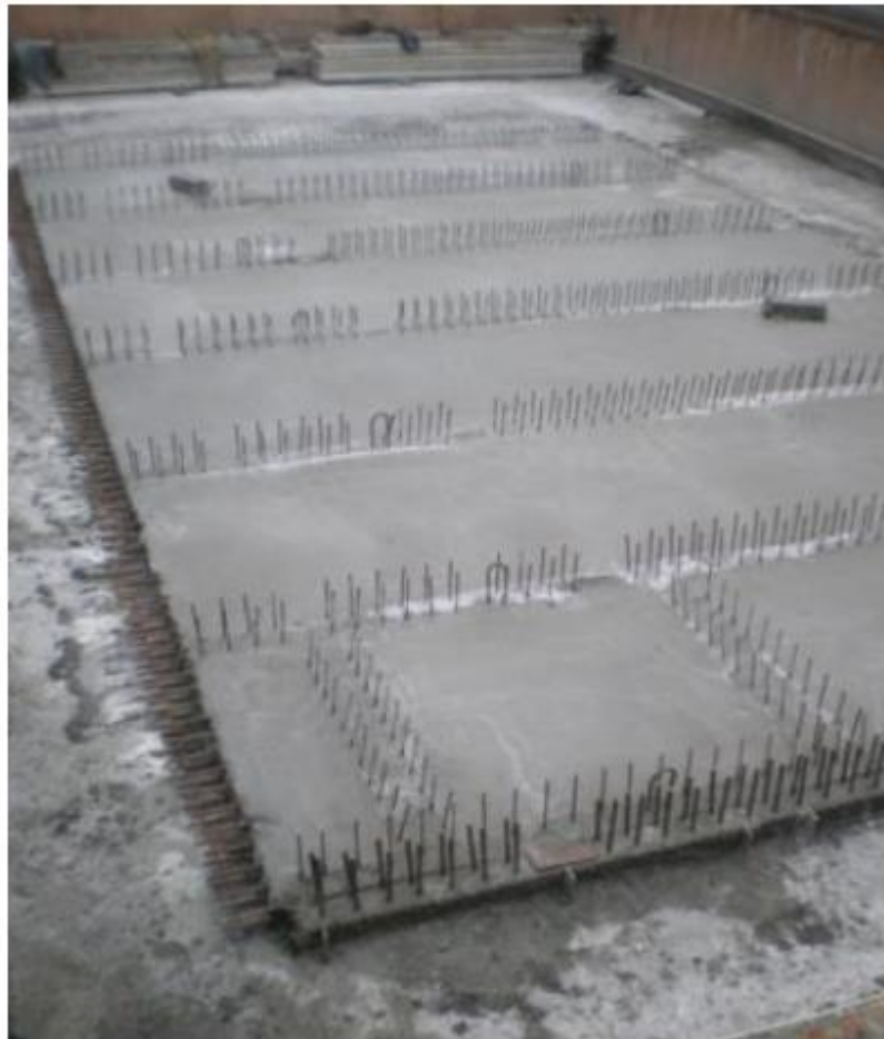
Рисунок 6.3. Плоска залізобетонна секція з закладними деталями та виходами, виготовлена на заводі для понтона дока.
