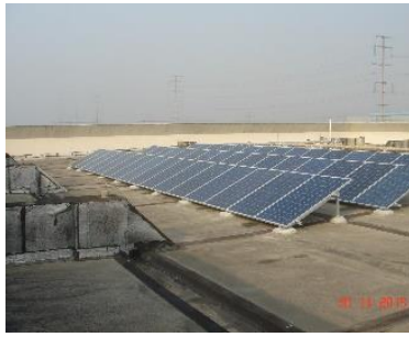
Монтаж елементів установки (2015)
